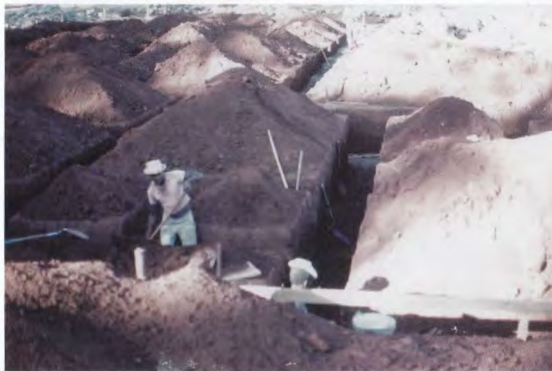
Il progetto del nuovo ambulatorio e lo scavo delle fondamenta.
